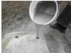
Masse sofort nach dem Mischen direkt aus dem Mischbehälter in die Bohrlöcher einfüllen. Wenn direktes Einfüllen nicht möglich ist, kann auch ein Trichter verwendet werden. **Verarbeitungszeit: 5 Minuten.**
